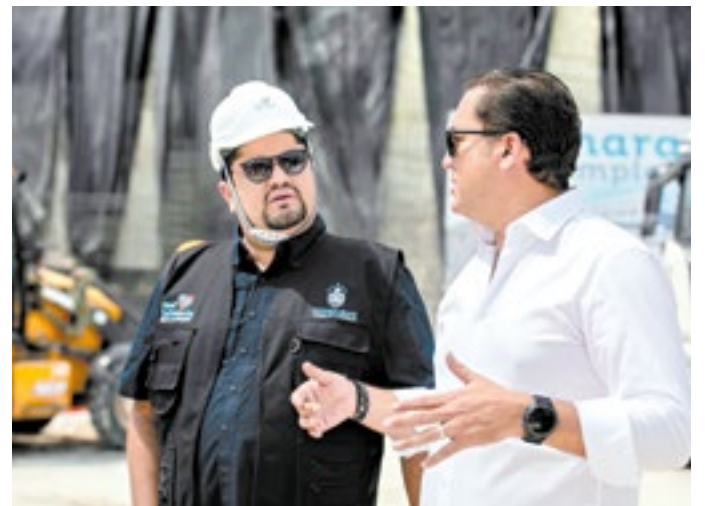
El Presidente de la CONFI, Héctor Zelaya, en compañía del ministro de SEDESOL, José Carlos Cardona, en la supervisión de la construcción del nuevo hospital.
