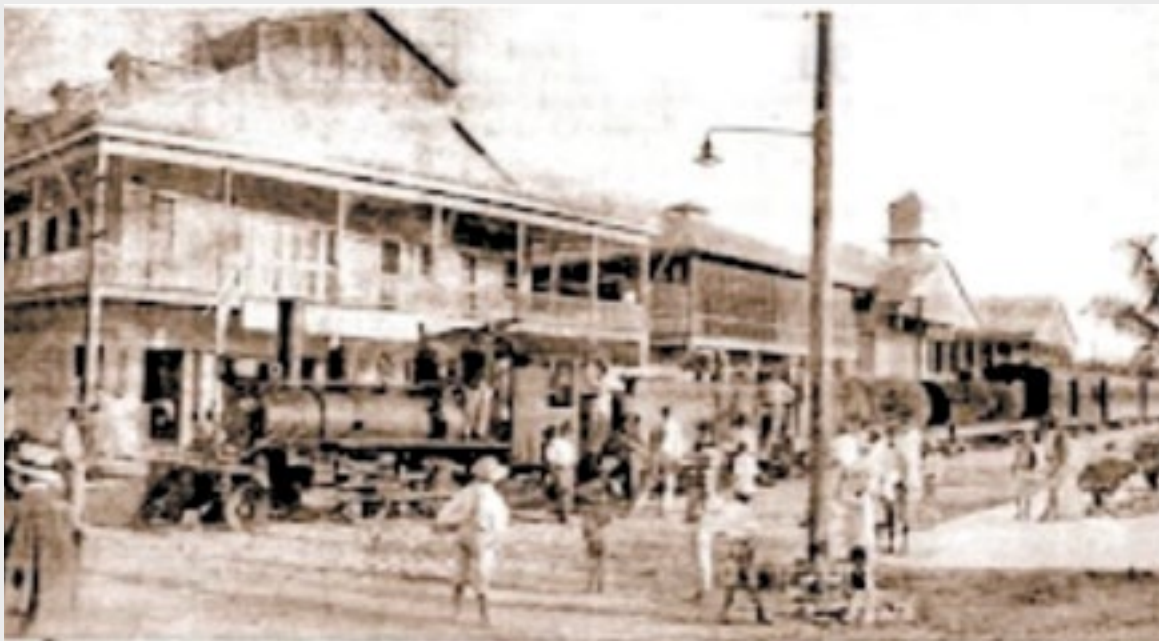
Máquinas del tren frente al Parque Central de La Ceiba a principios del siglo XX
