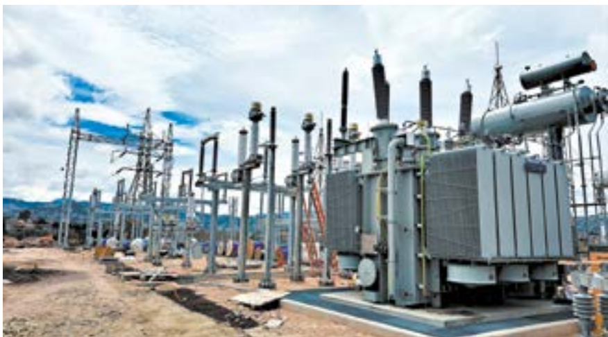
Ampliación subestación Miraflores.
