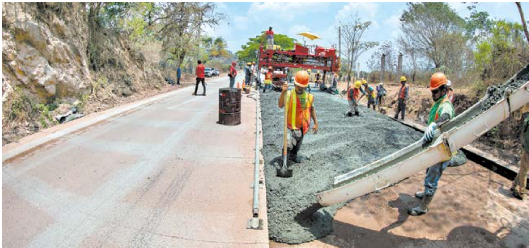
En la imagen parte del personal de trabajo de la SIT, donde realizan colocación del concreto hidráulico en la carretera.
