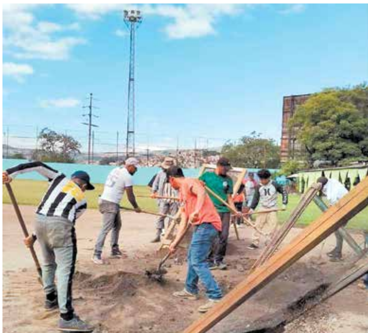
Los trabajos de mantenimiento y acondicionamiento no paran, porque la Copa Ara Macao inicia este 12.
