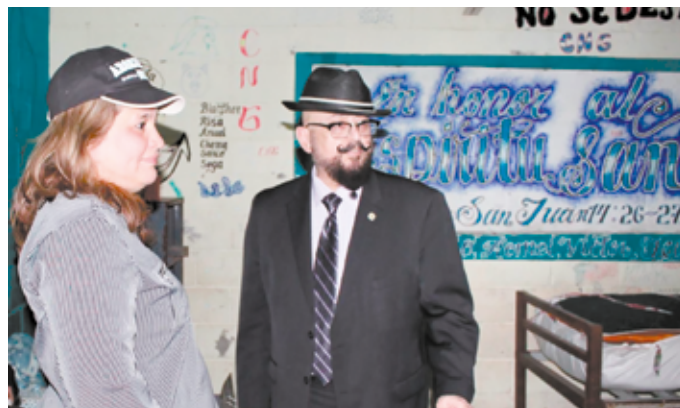
La viceministra Julissa Villanueva realizó un recorrido por las instalaciones para ver el estado físico del lugar en compañía del asesor penitenciario Orlando Ybarra de la embajada de Estados Unidos.
