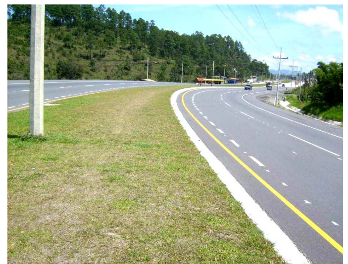
Se elaboran rótulos para nuevos proyectos carreteros.
