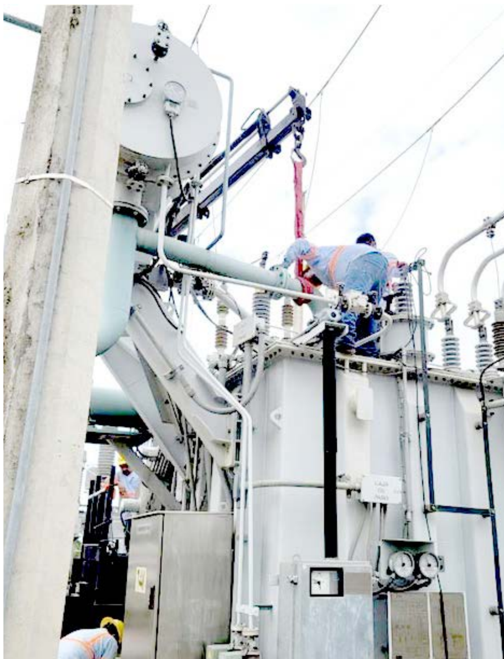
El equipo técnico trabaja en el cambio de las líneas obsoletas para que no haya pérdida de energía.
