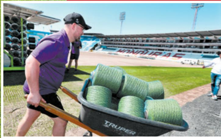
Los trabajadores están agilizando la instalación de la grama híbrida para que la máquina cosedora trabaje rápidamente.
