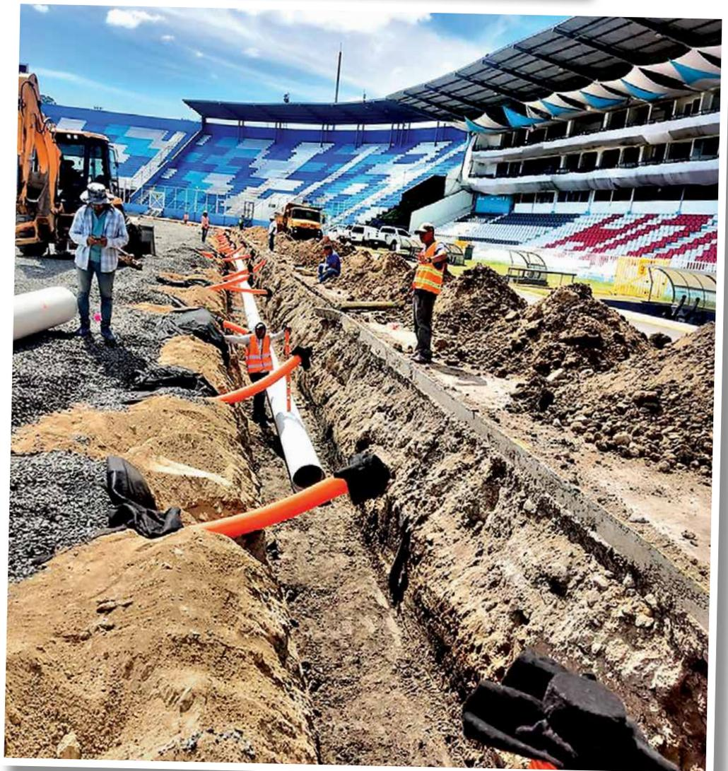
Por ahora se está trabajando en la instalación de la tubería del drenaje, para luego colocar el sistema de riego.
