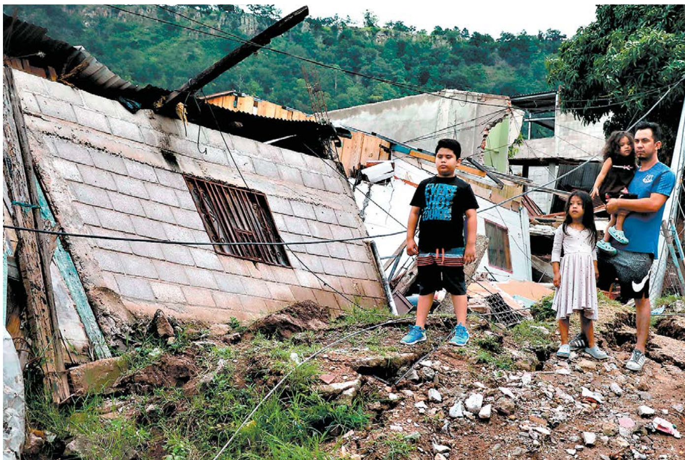
Un monto total de 4,077,000 lempiras recibirán las familias afectadas de la colonia Guillén para subsidiar el pago de renta ante la pérdida de su vivienda.
