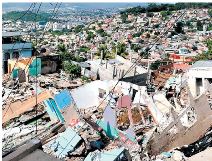
Al menos 453 familias afectadas por los deslizamientos en la colonia Guillén y colonias adyacentes recibirán subsidio para pagar la renta
