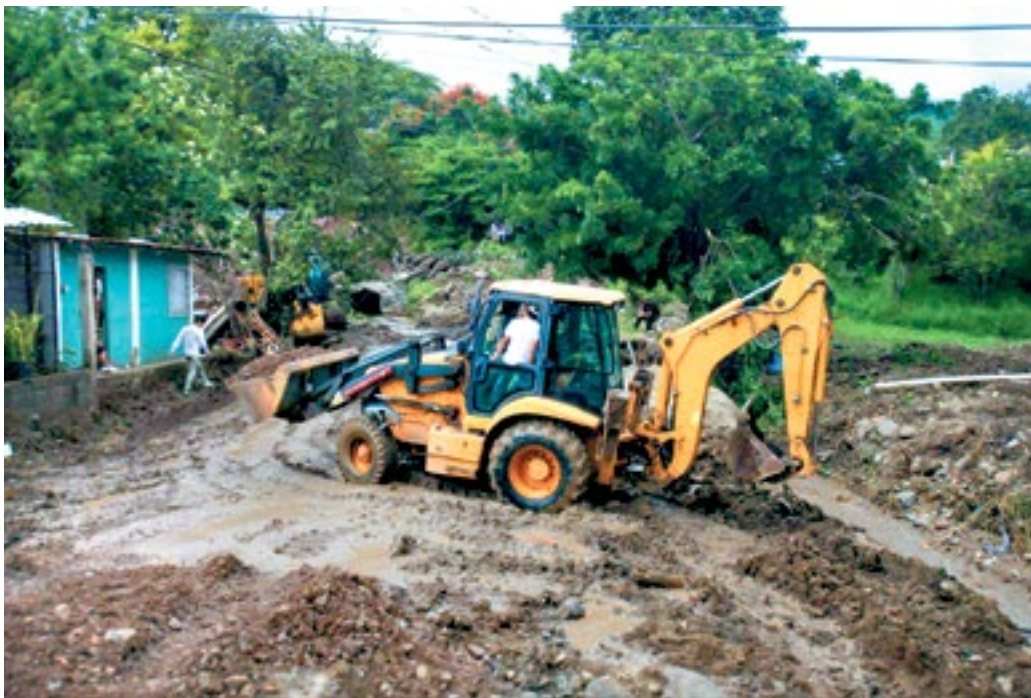
Retroexcavadora de la alcaldía trabajando en el drenaje y apertura de cauces para prevenir inundaciones en áreas vulnerables.
