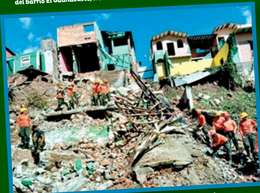
Las Fuerzas Armadas, mediante su Unidad Humanitaria y de Rescate, remueve escombros en el barrio El Reparto, tras las lluvias, para despejar accesos y proteger a los habitantes.
