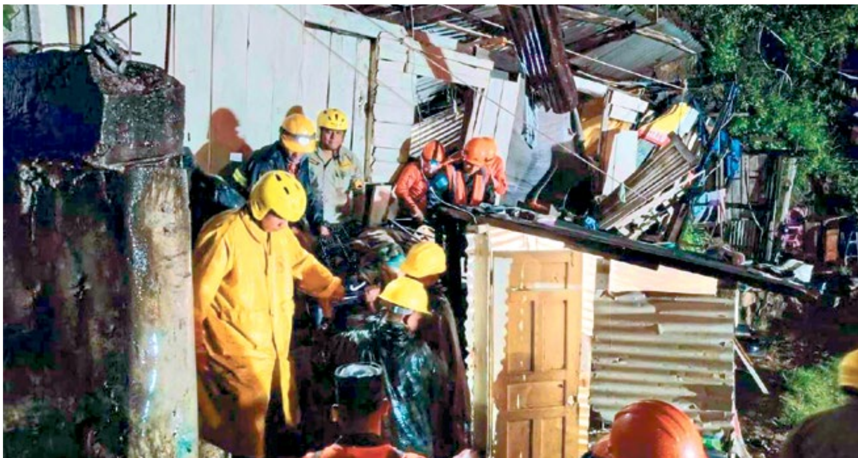
El derrumbe de rocas por las intensas lluvias causó el colapso de una pared de madera y el techo de láminas de zinc de la vivienda, provocando que la muchacha muriera soterrada.
