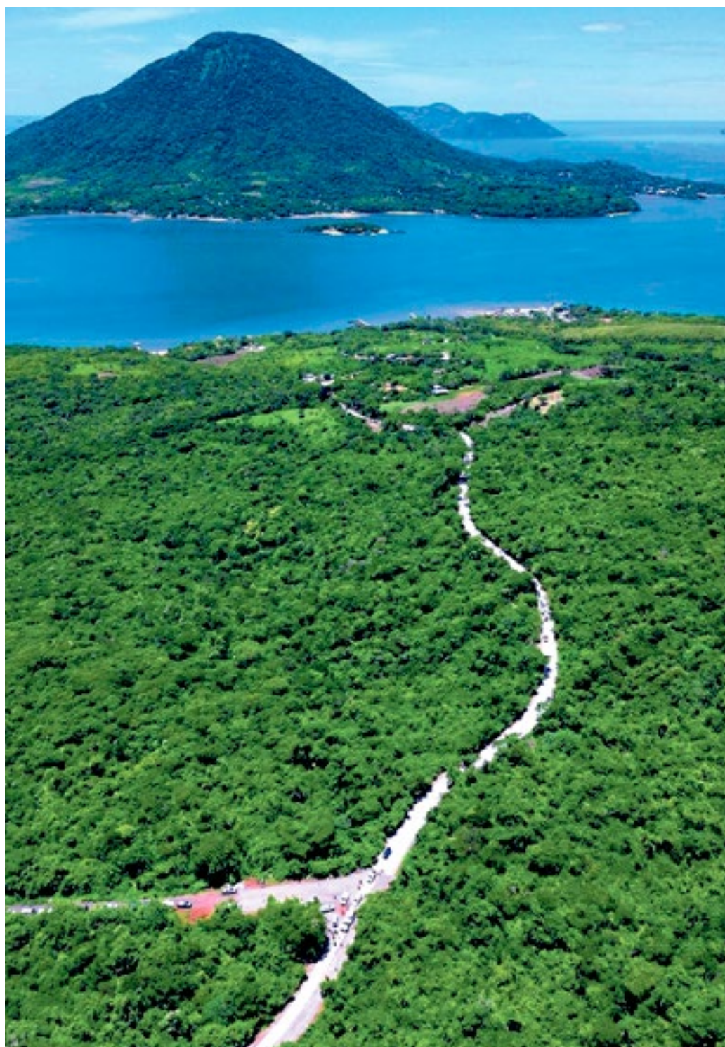
Toma aérea de los trabajos en el tramo carretero Alto Verde-Coyolito, una vía estratégica para la conectividad en el sur del país.
