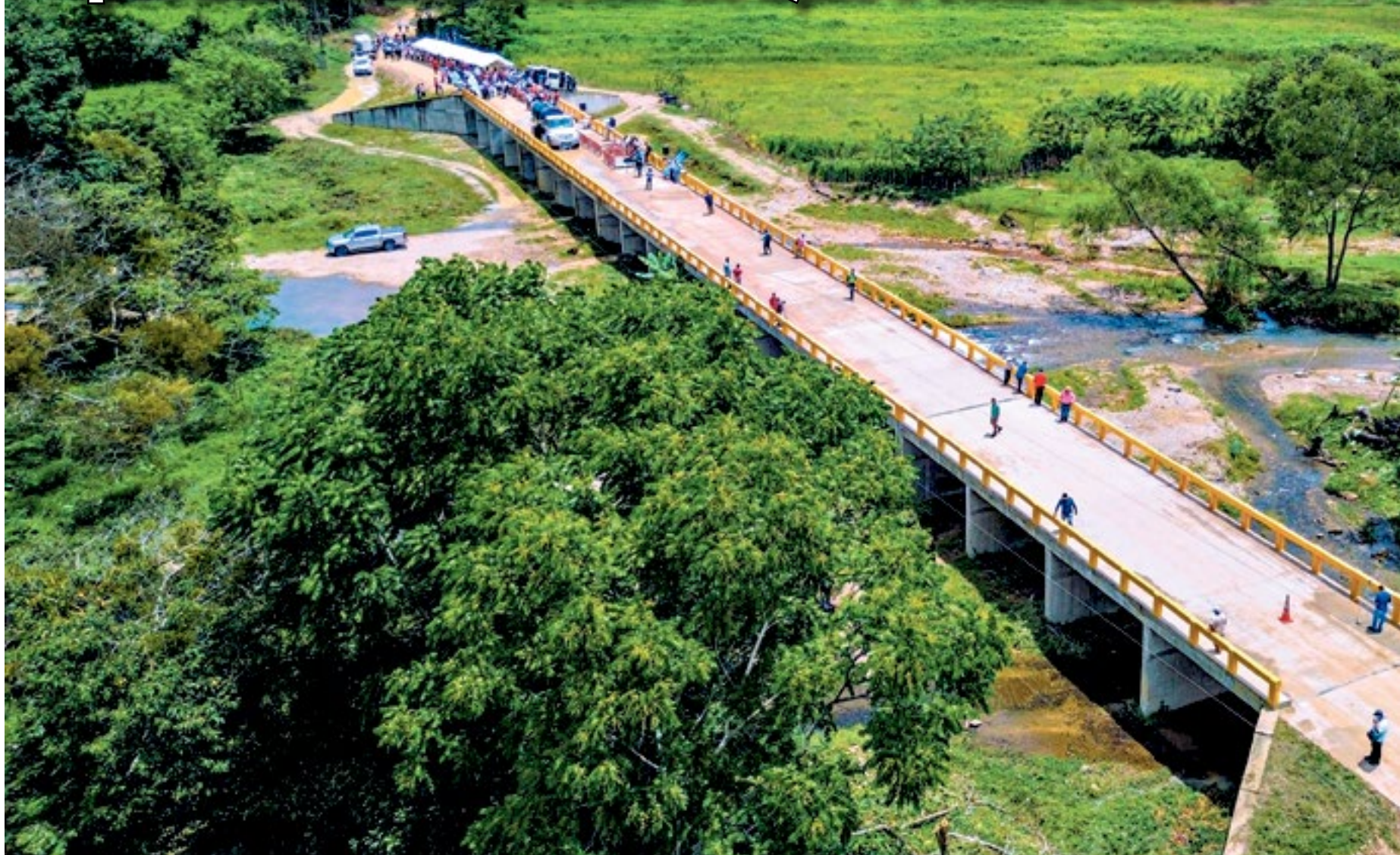
Vista panorámica de la caja puente construida por el FHIS, en la aldea San Pedro de Pisijire, en Dulce Nombre de Culmí, Olancho.
