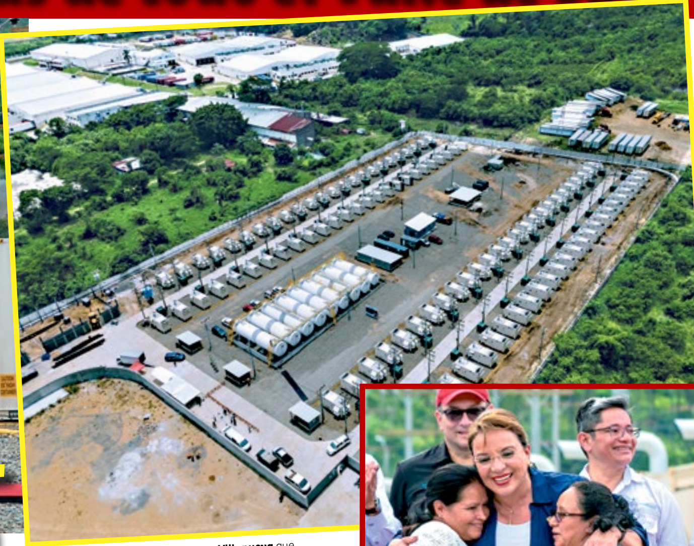
Vista aérea de la mega planta en Villanueva que supera los 1,250 millones de lempiras que evitará la sobrecarga de la subestación Villanueva.
