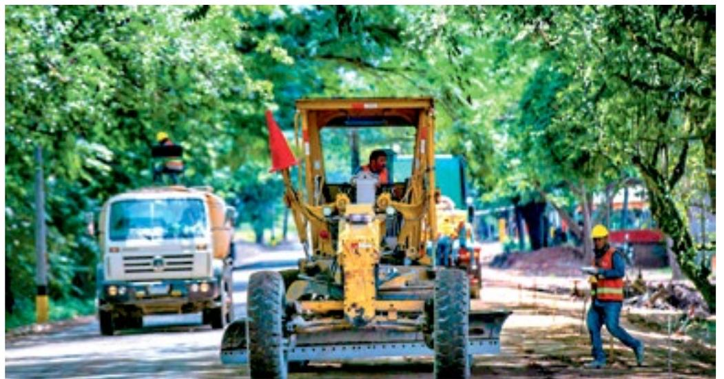
**Los trabajos avanzan** significativamente en el sector con el objetivo de completar la primera fase e iniciar la colocación de la capa de concreto hidráulico.
