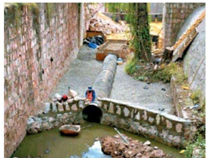
**Equipos de trabajo refuerzan los muros** de contención de las orillas de la caja puente en colonia Las Colinas, de Tegucigalpa.
