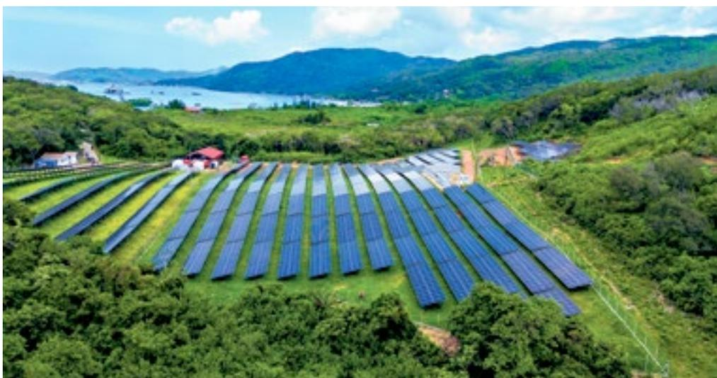
El proyecto PERLA Guanaja I, cuenta con una capacidad solar de 600 kWp, almacenamiento en baterías de 576 kWh y un sistema de respaldo con generación térmica de 3184 kVA.
