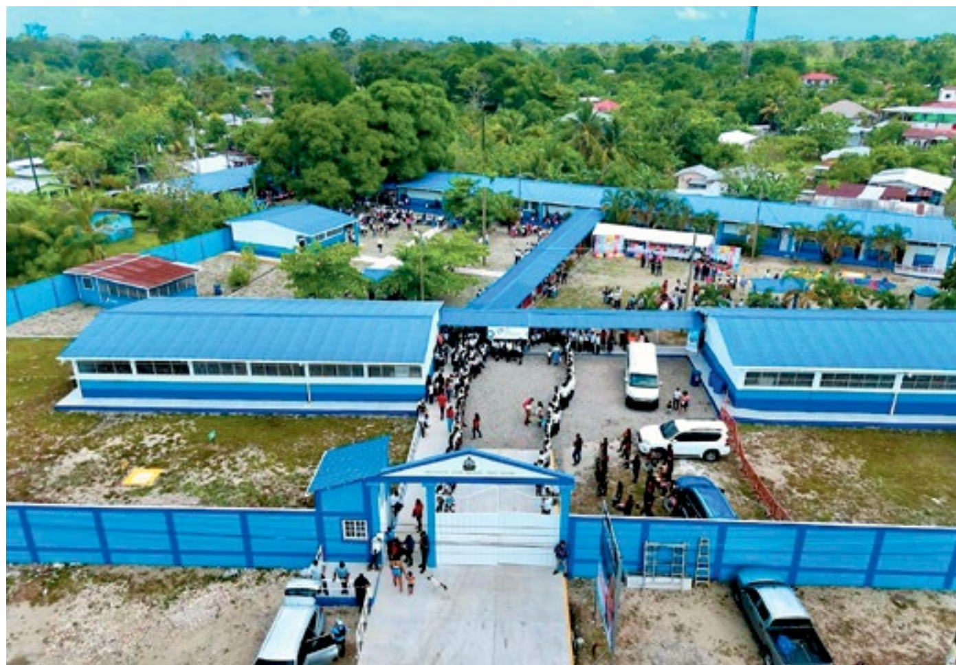
La reconstrucción del centro educativo se hizo mediante una inversión de 18 millones de lempiras y beneficiará a 240 estudiantes en la comunidad de La Unión, El Porvenir, Atlántida.
