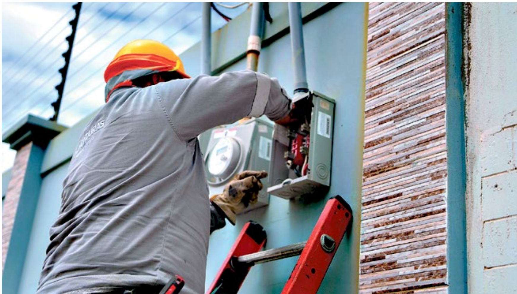
Cuadrillas del PNRP realizan el corte de suministro eléctrico de una conexión ilegal que mantenía esta instalación.
